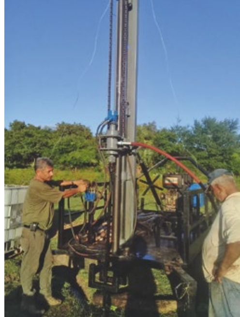
Erstes Brunnenbohrgerät für Kleinbauern im Einsatz
