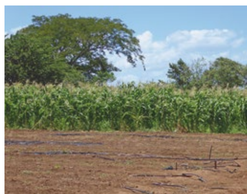
Installation von Tropfenbewässerung auf der Ausbildungsfinca „San Roque“
