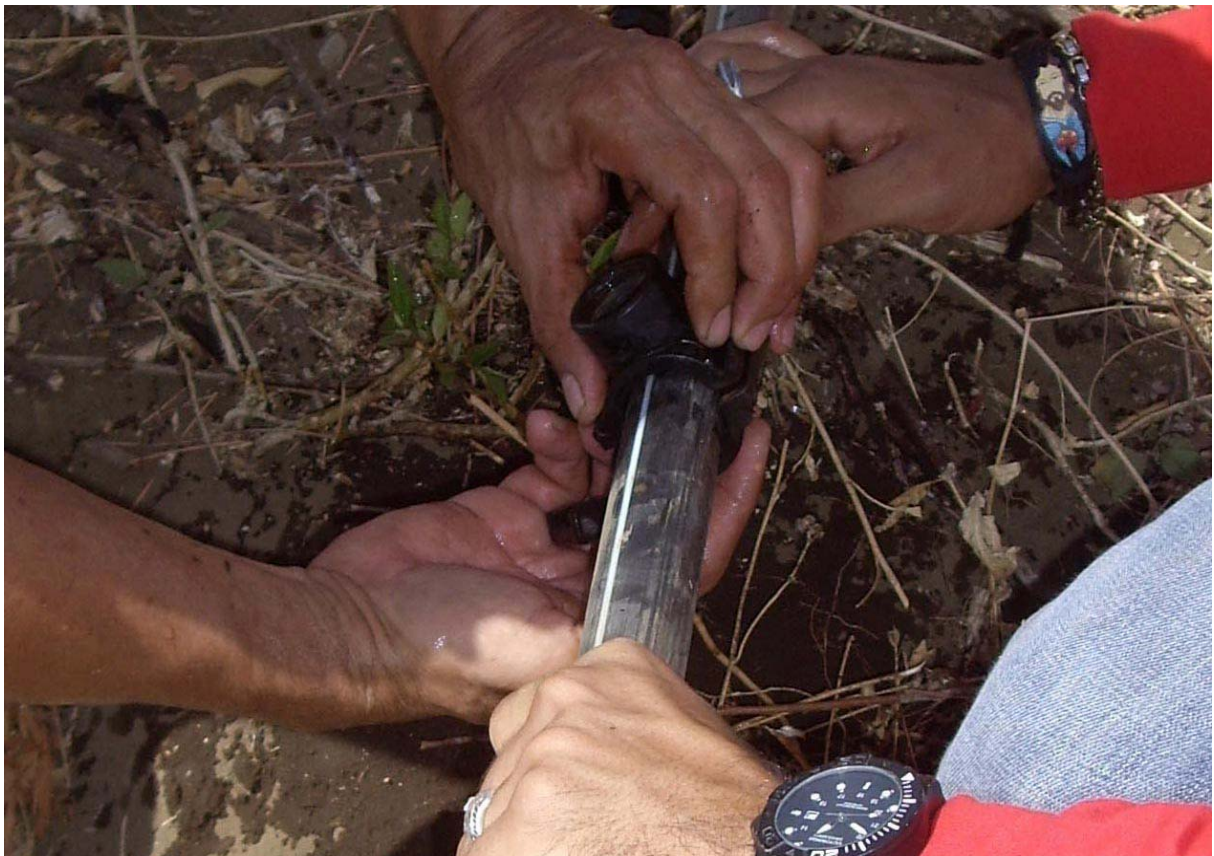
Montaje del conductor que permite la conexión a las cintas de goteo.
