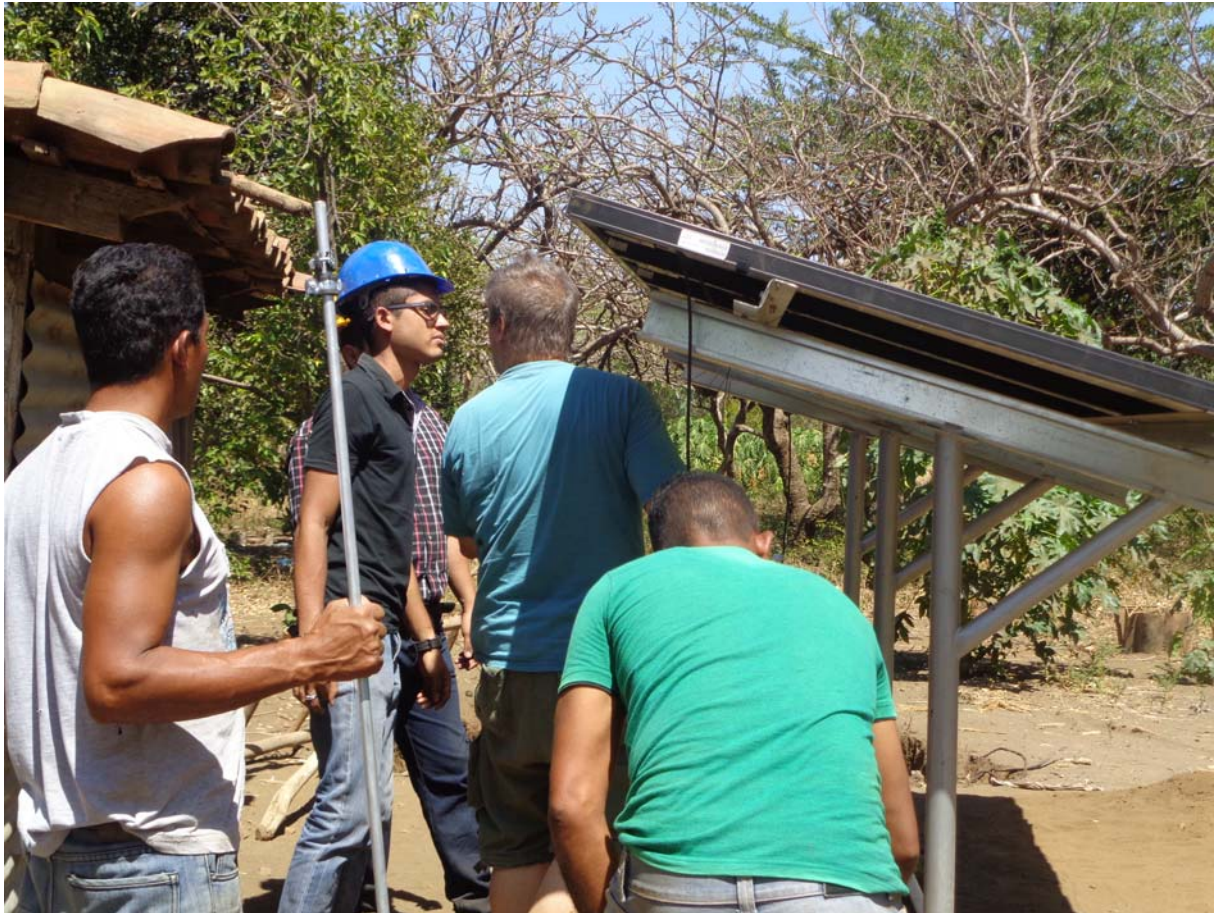
Montaje de la estructura para los paneles solares
