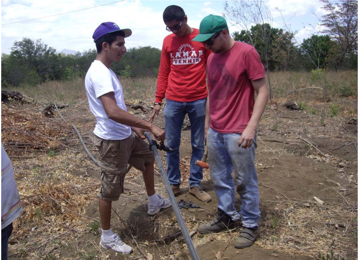
El tendido de la tubería principal para el sistema de riego por goteo
