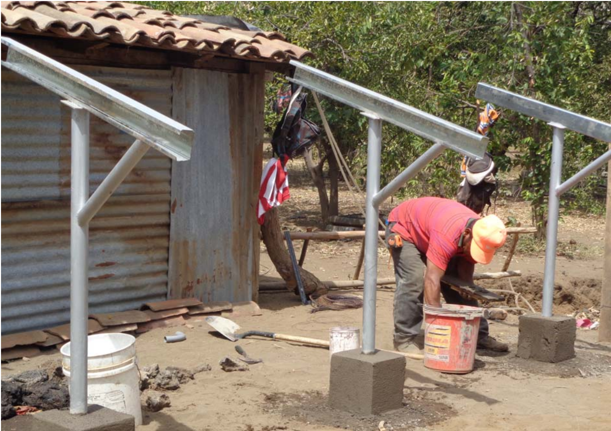
La instalación de los paneles es empotrado con base de concreto
